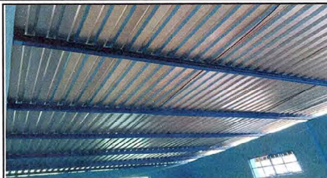
Foto 2: Parte internade aulas con cubierta de lámina troquelada instalada y estructura de metal con mantenimiento aplicado.
