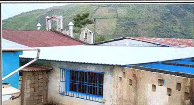
Foto1: Aulas 1 y 2 Cubierta de Lámina Troquelada Calibre 26 instalada, Balcón y Ventana terminados.
