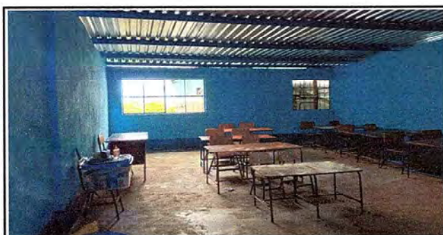
Foto 5: Ambiente interno de las aulas intervenidas con pintura aplicada.
