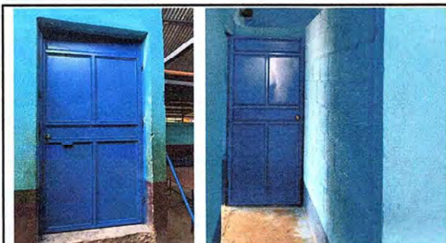
Foto 3: Puertas de metal instaladas, paredes de block terminadas y aplicación de pintura.
