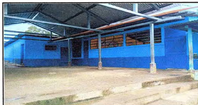
Foto 6: Aulas y Dirección intervenidas con sustitución de lámina, mantenimiento de estructura de techo, paredes, balcones, ventanas y aplicación de pintura.
